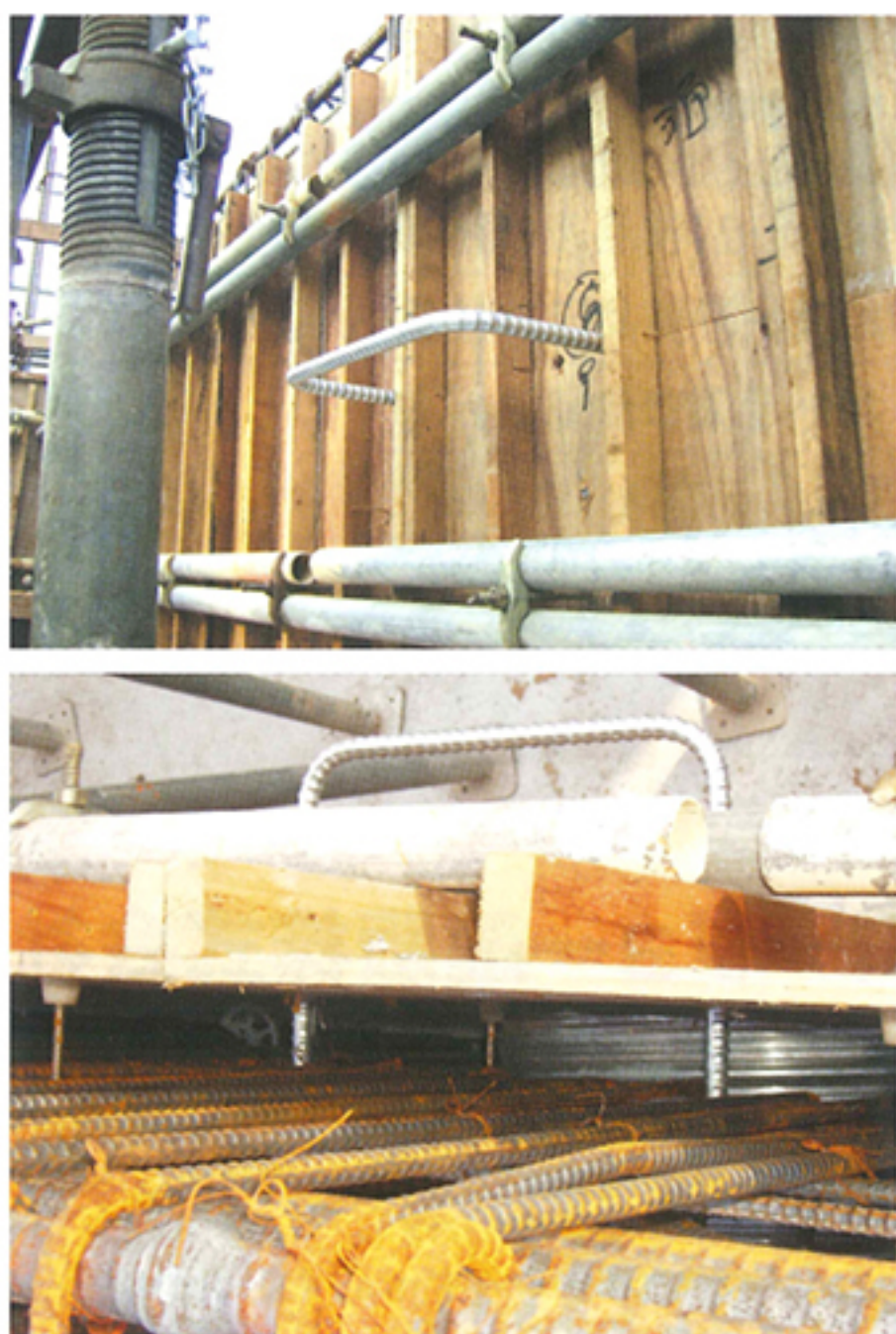
人通孔上部タラップ（正面および上部からの様子）
