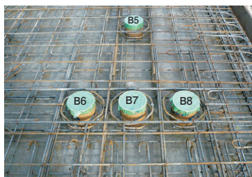
溶接閉鎖形補強の配筋状況 (B5:φ150×1, B6~B8:φ150×3)
